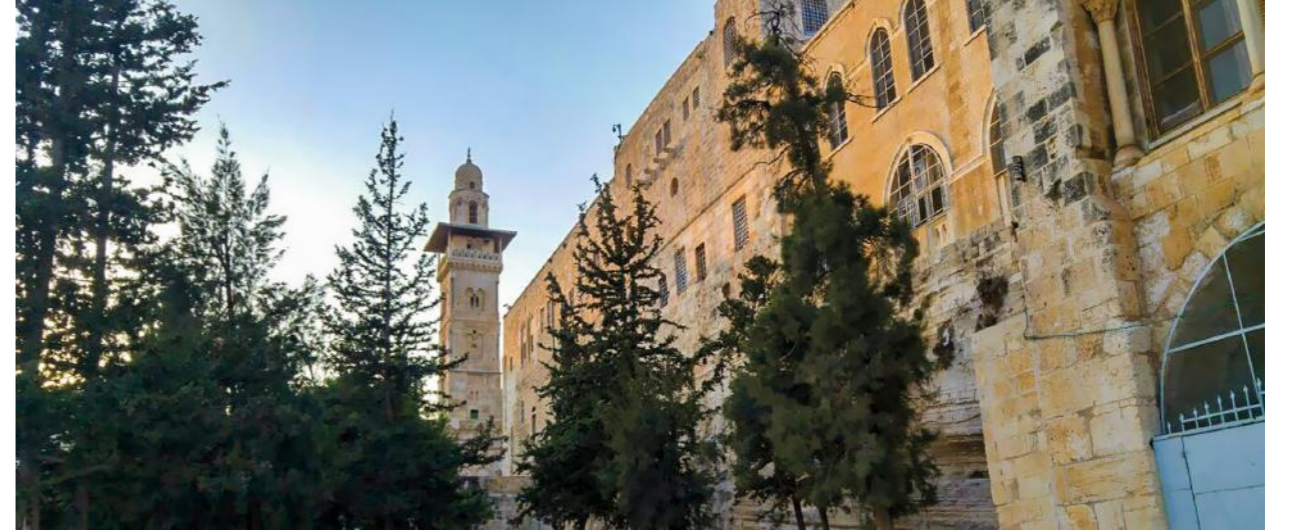
Kuzey Revaklardaki Medreseler
